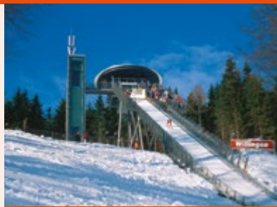
Naar boven en beneden per kabelspoor
